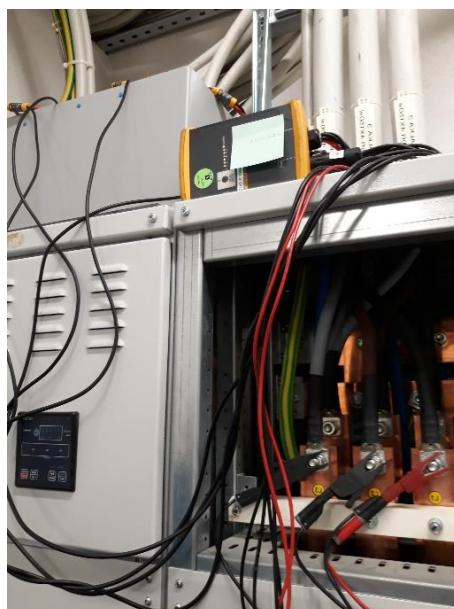
Slika 8 Prikaz vgrajenega analizatorja za izvedbo meritev.
